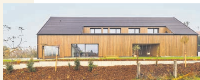
Das Haus in Backnang bietet Platz für eine Familie mit vier Kindern. Rechts neben dem überdachten Durchgang ist die Garage.
