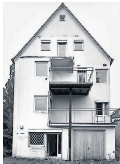
Das Haus vor dem Umbau ... Foto: NK
